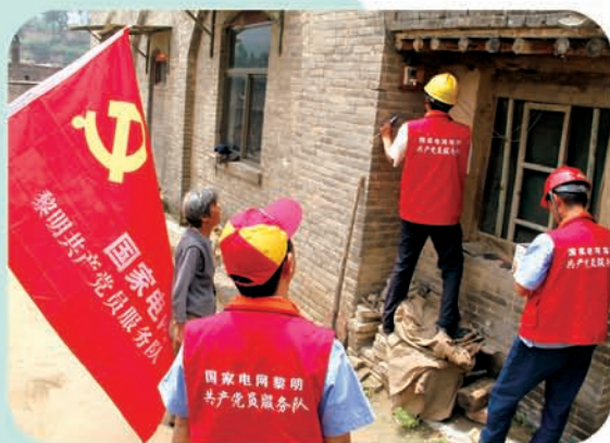
2012年7月14日，公司黎明共产党员服务队开展敬老助残活动，为老人义务维修用电线路
