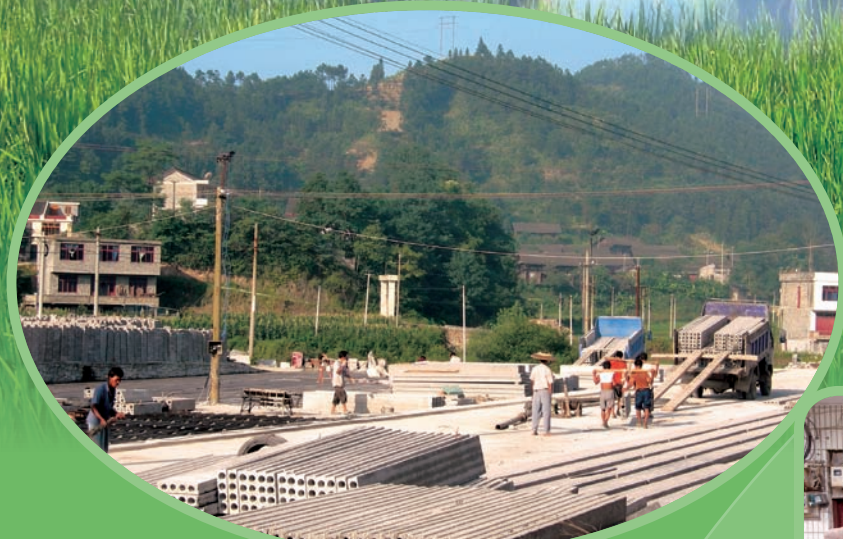
正在崛起的集体经济——对河预制板场
